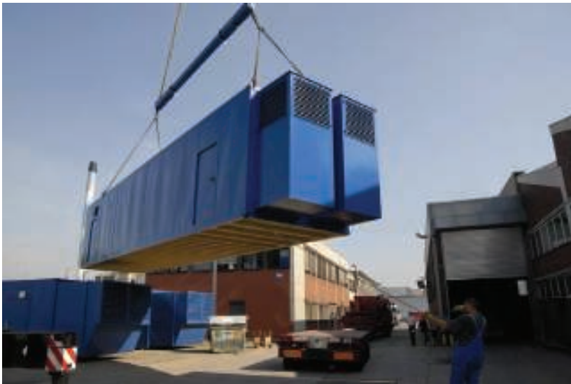
Рис. 18.13 Подъем контейнера с помощью траверсы
