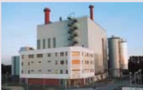
Районная отопительная ТЭЦ во Франкфурте на Одере (Германия), на базе SGT-600.
